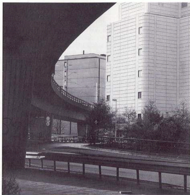
Dynamisch Den Haag. Links: de bouwput voor het nieuwe stadhuis. Midden: tramviaduct naast de Koninklijke Bibliotheek. Rechts: gebouw Terminal, Prins Bernard viaduct.
